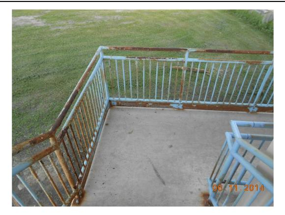
TYPICAL CORROSION ON STAIRCASE RAILING AT PIER 2
